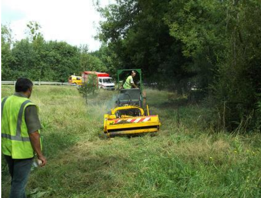
Essai en cours de broyage
